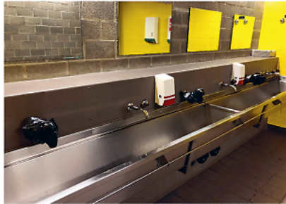
Fig 8 : Robinets d'eau bouchés
